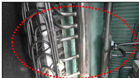
【Spray R-Pro on pipe & other parts】
