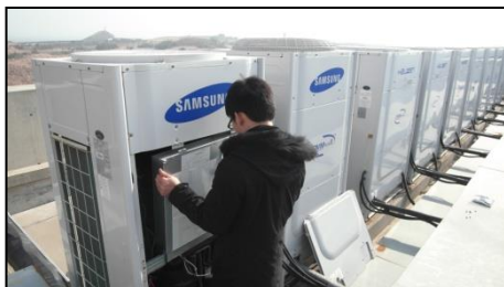
【Separate the outdoor panel】
